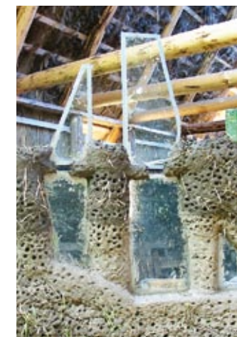
► Glas kan bygges direkte ind i cob-væggen. Her noget glas, som ellers ville være endt på lossepladsen.
